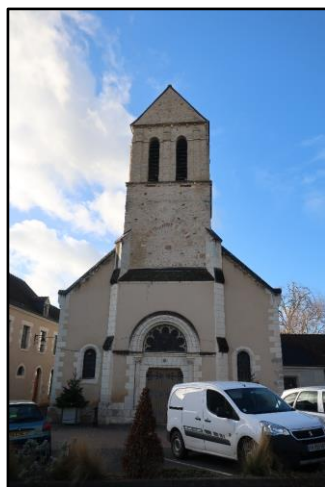
Eglise paroissiale Saint-Etienne (Reignac-sur-Indre) Source : L'Artifex 2018
